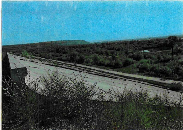
Fig. 3 Vedere din aval spre amonte a pereului betonat al digului mal drept al AHE Făgăraș-Hoghiz
