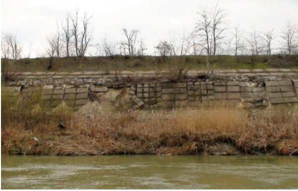
Figura 2-24. Protecție taluz degradată
