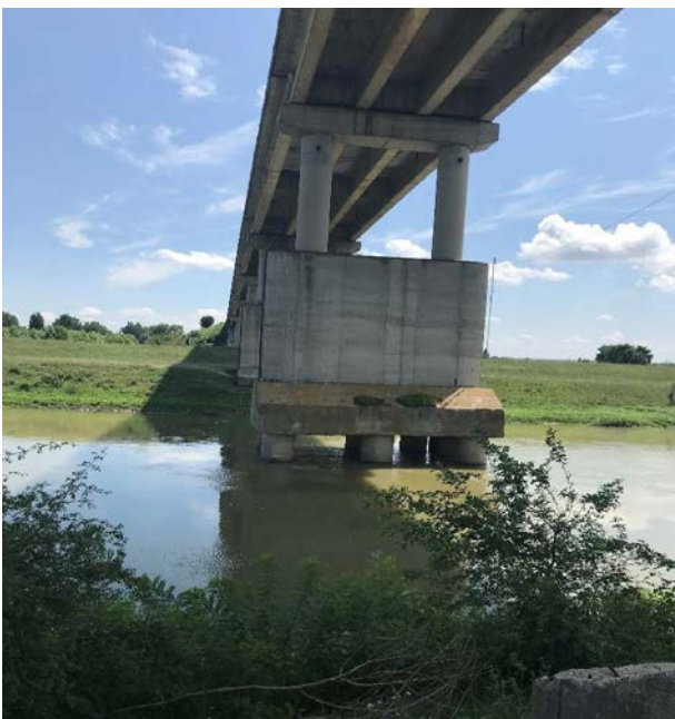
Figura 2-26. Pod peste râul Argeș la Oltenița cu infrastructura afectată de eroziunea albiei râului
