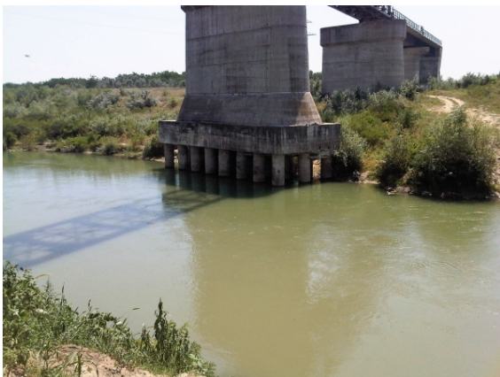
Figura 2-25. Pod nou CF la Grădiștea afectat de eroziunea albiei
