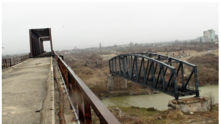
Figura 2-25. Pod nou CF la Grădiștea afectat de eroziunea albiei
